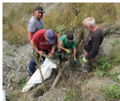
სურათი 37: მცენარეებით დაფარული პალისადები
