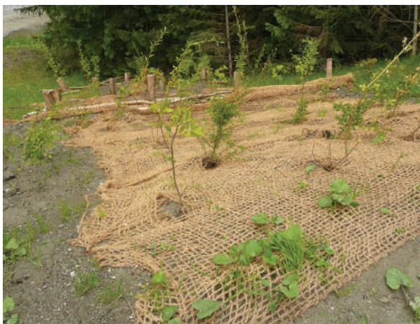
სურათი 19: დაშლადი ბადეები, რომლებიც თივის მულჩის დასაფარად გამოიყენება (მარცხნივ), სასუქის და მულჩის ნარევი (მარჯვნივ)
