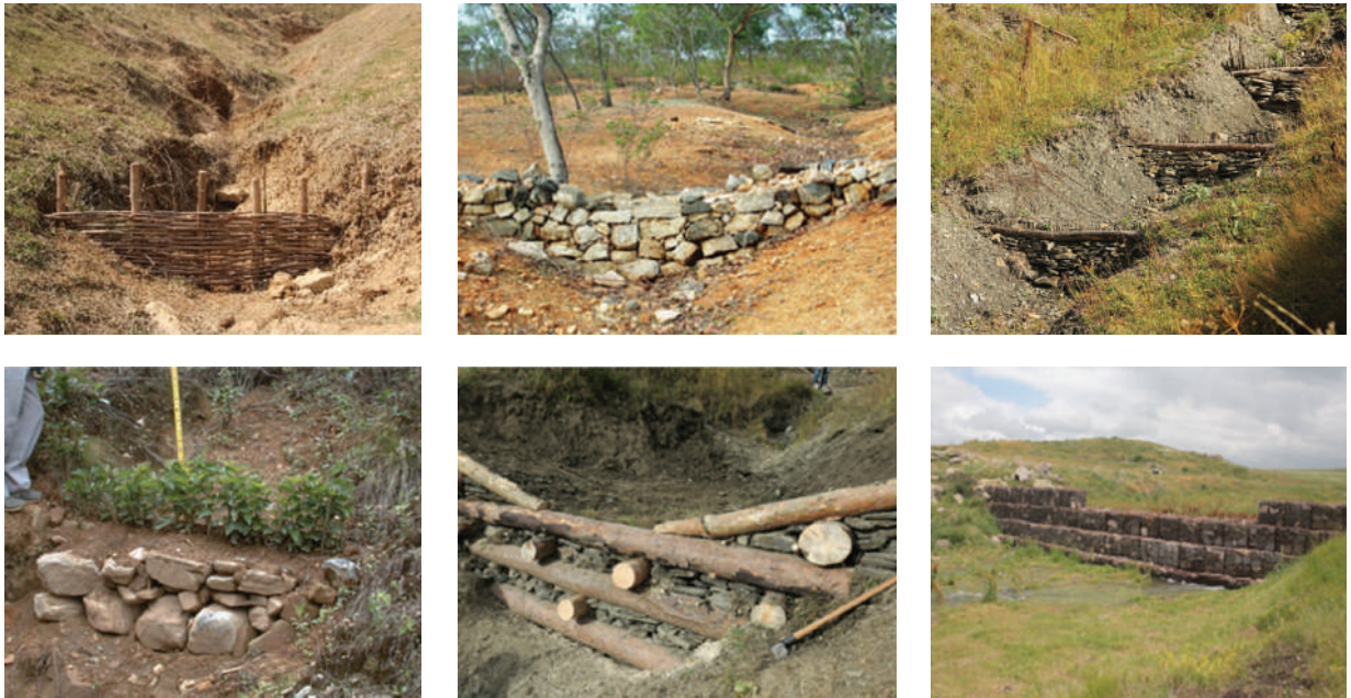
სურათი 22: სხვადასხვა მასალისგან დამზადებული ხევის დამცავი დამბები
