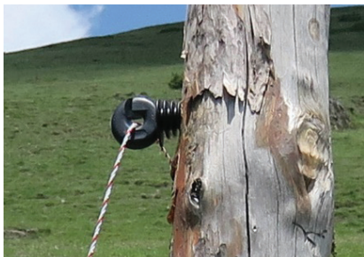
Նկար 2՝ Հաղորդալարերի ամրացումը ձողերին
