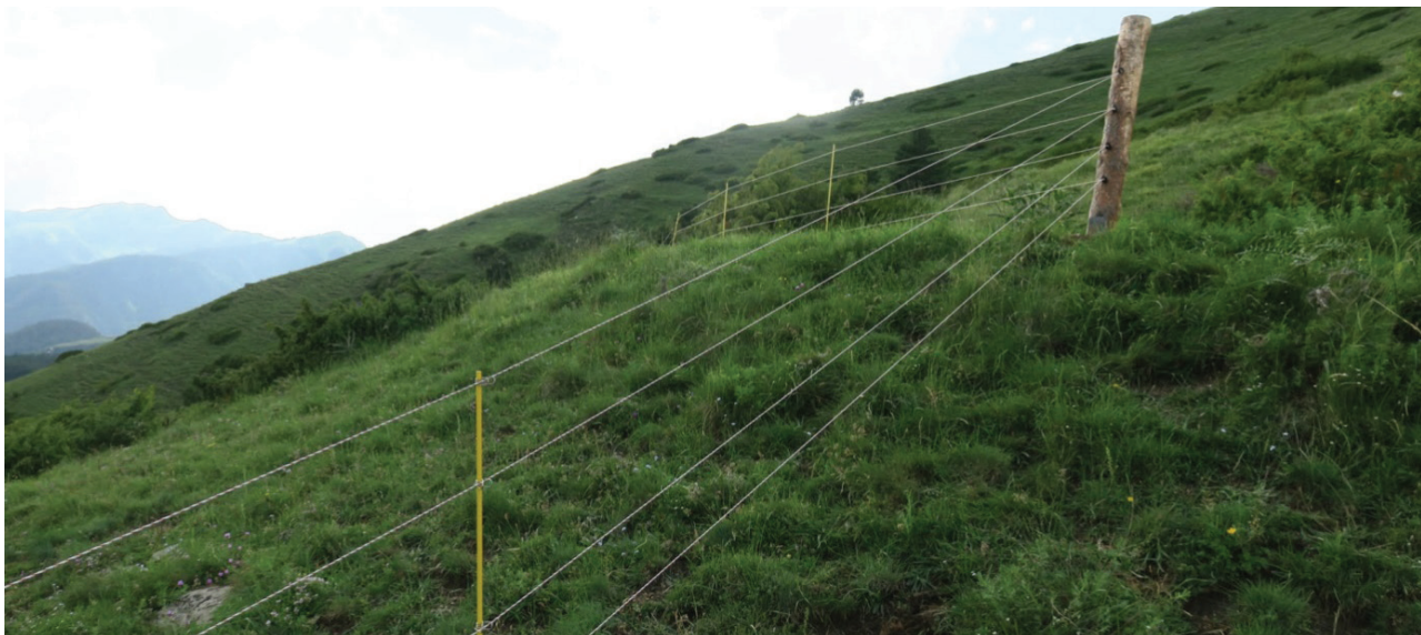
Նկար 3՝ Դեղին ֆիբրե ծողերի տեղադրումը յուր. 5մ մեկ և լարերի ամրացումը
