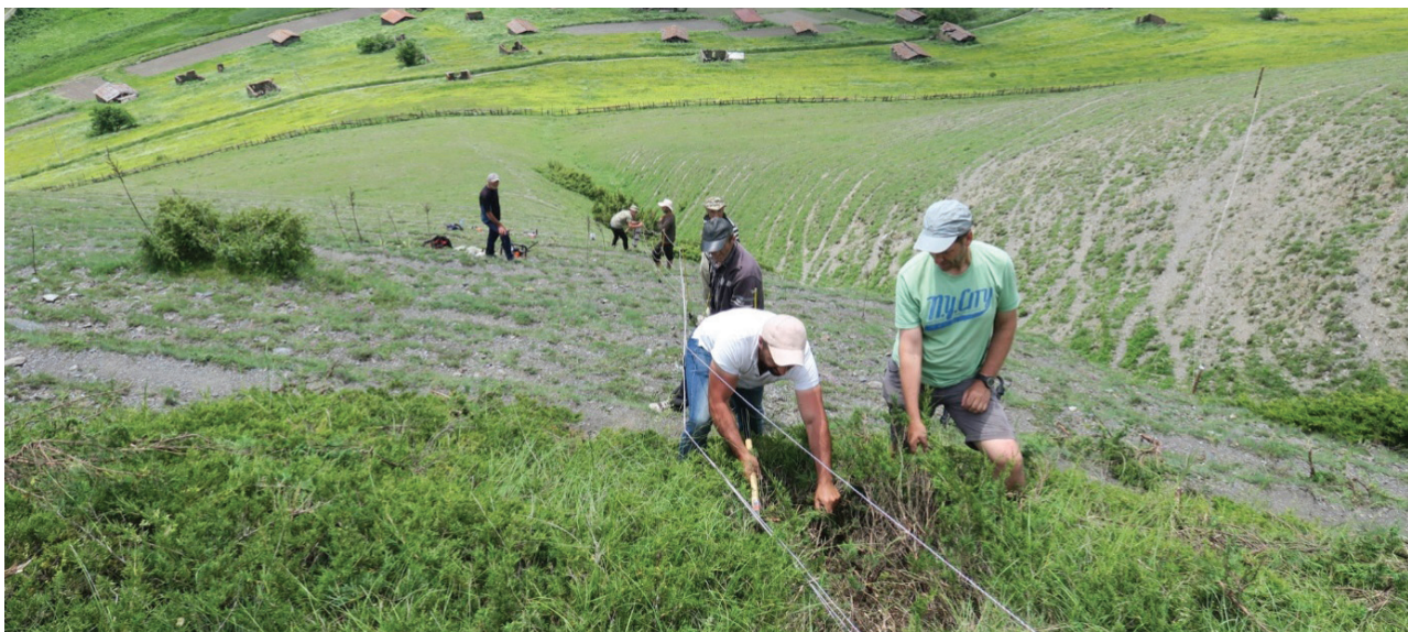
Նկար 4՝ Հաղորդալարերի շփման խուսափումը բուսածածկի հետ (անհրաժեշտության դեպքում մաքրել բուսածածկը)
