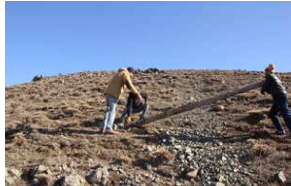
Պատկեր 3. Լանջի երկայնքով գերանների տեղադրումը ճիշտ դիրքադրությամբ (նոյեմբեր, 2016 թ.)
