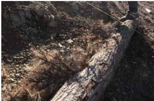
Պատկեր 4. Գերանների ետևում ընկած բաց տարածությունը լցվում է հողով և բուսական ծածկան նյութերով (ձախից) և լերկ հողը ծածկվում է ծղոտով (աջից) (նոյեմբեր, 2016 թ.)
