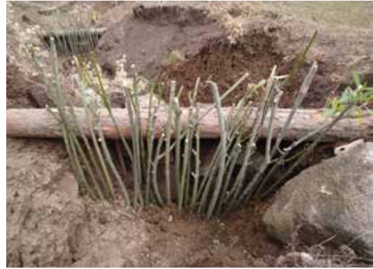
Պատկեր 4. Ծառերի կտրոնների տեղադրում փայտե գերանների ետին հատվածում
