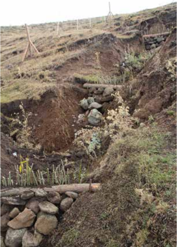
Պատկեր 7. Հենապատնեջ՝ հեղեղատում ջրի հոսքը նվազեցնելու նպատակով
