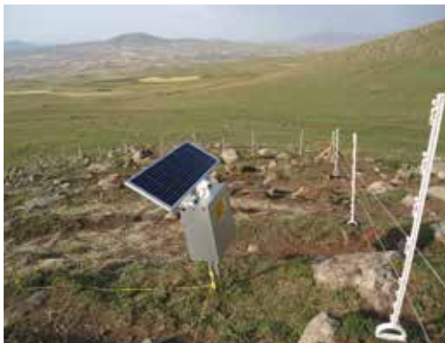
Պատկեր 2 Արևային վահանակ, սնուցող սարք (ձախից) և էլեկտրական ցանկապատը՝ օդային էլեկտրահաղորդակցման լարերով (աջից)
