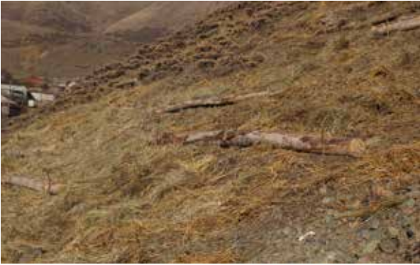
Պատկեր 5. Դարավանդներն ու մուլչապատումը կիրառվում են լանջերում խորացող մակերեսային էրոզիայի դեմ պայքարում
