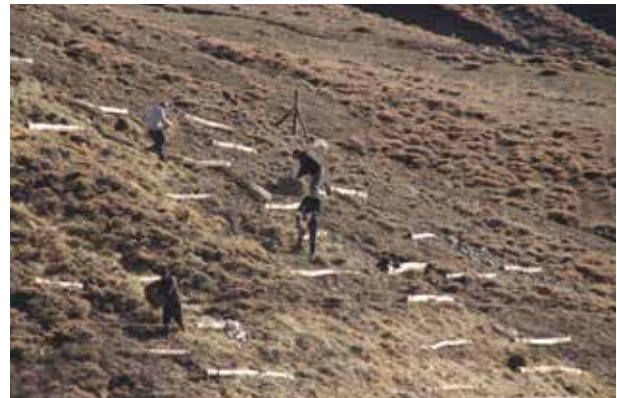
Պատկեր 4. Գերանների ետևում ընկած բաց տարածությունը լցվում է հողով և բուսական ծածկան նյութերով (ձախից) և լերկ հողը ծածկվում է ծղոտով (աջից) (նոյեմբեր, 2016 թ.)
